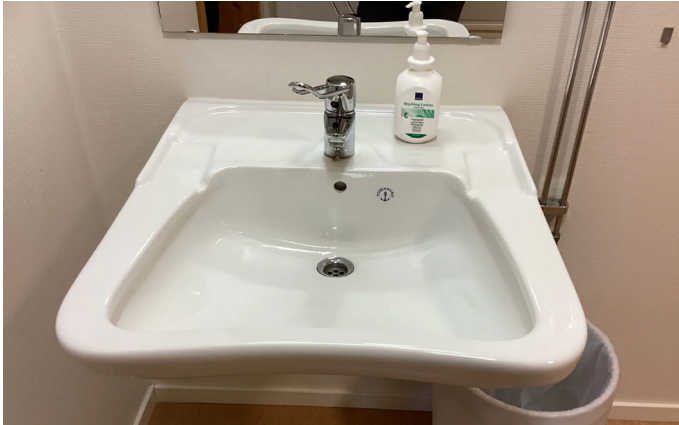
Bilde 22: Eksempel på bygningsdelskode 315
