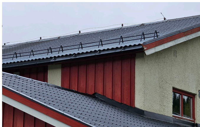
Bilde 19: Eksempel på bygningsdelskode 26
