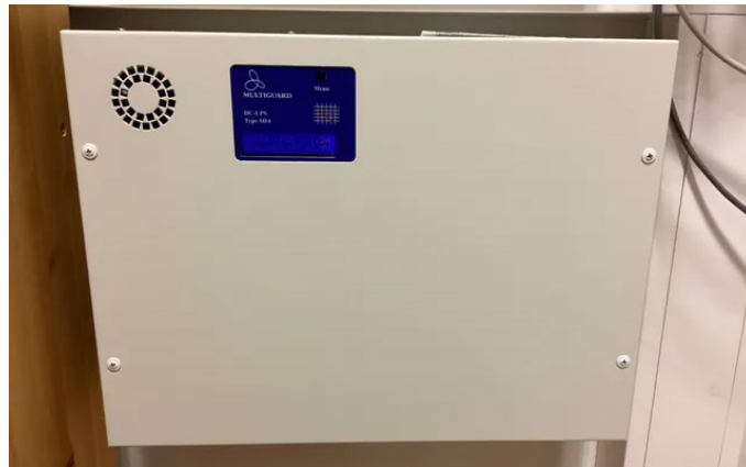
Bilde 32: Eksempel på bygningsdelskode 542
