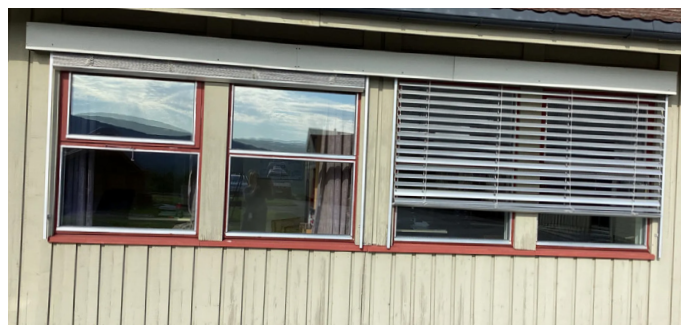
Bilde 14: Eksempel på bygningsdelskode 237
