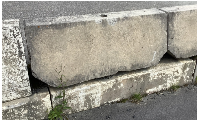
Bilde 36: Eksempel på bygningsdelskode 721
