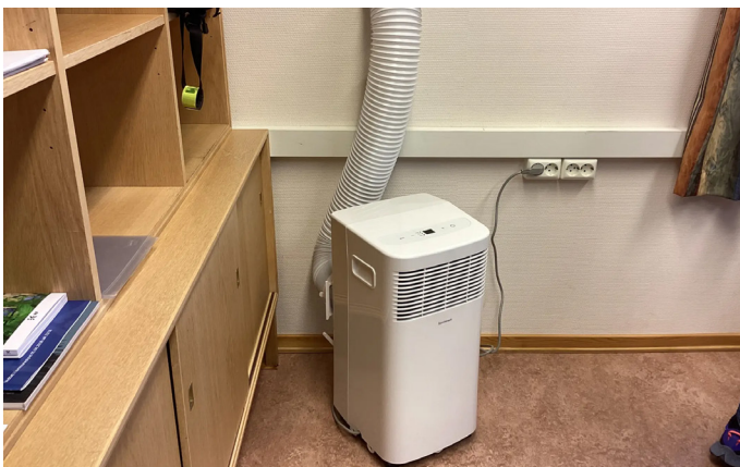
Bilde 27: Eksempel på bygningsdelskode 375
