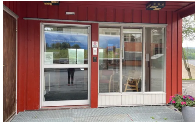
Bilde 13: Eksempel på bygningsdelskode 234
