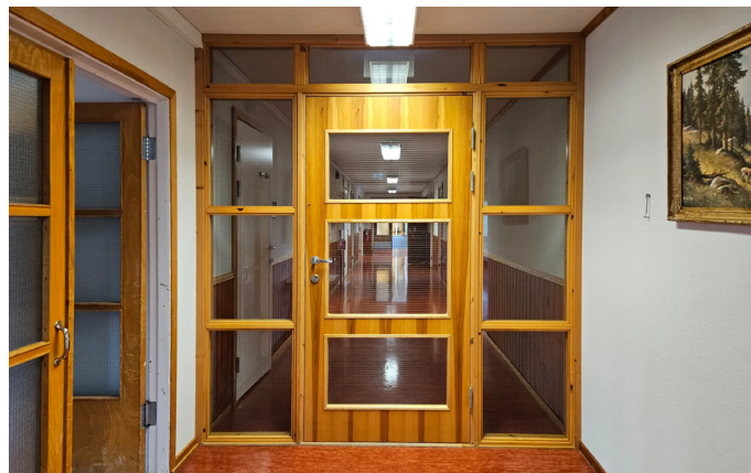
Bilde 16: Eksempel på bygningsdelskode 243
