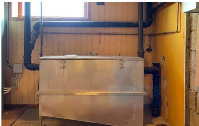
Bilde 28: Eksempel på bygningsdelskode 381
