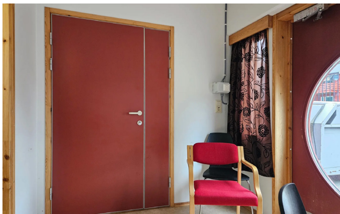
Bilde 15: Eksempel på bygningsdelskode 2442
