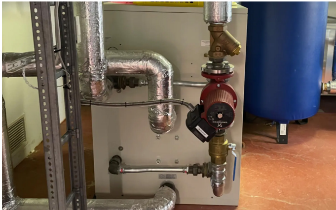
Bilde 24: Eksempel på bygningsdelskode 325
