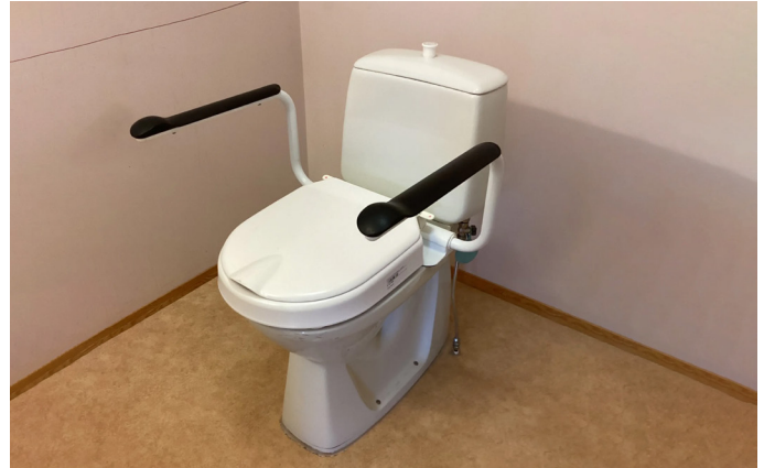
Bilde 23: Eksempel på bygningsdelskode 315
