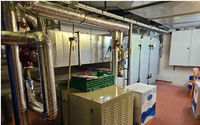
Bilde 26: Eksempel på bygningsdelskode 365
