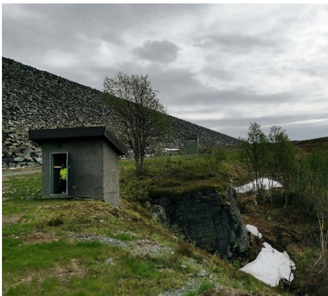
Adkomsthus til lekkasjemålepunkt 1.
