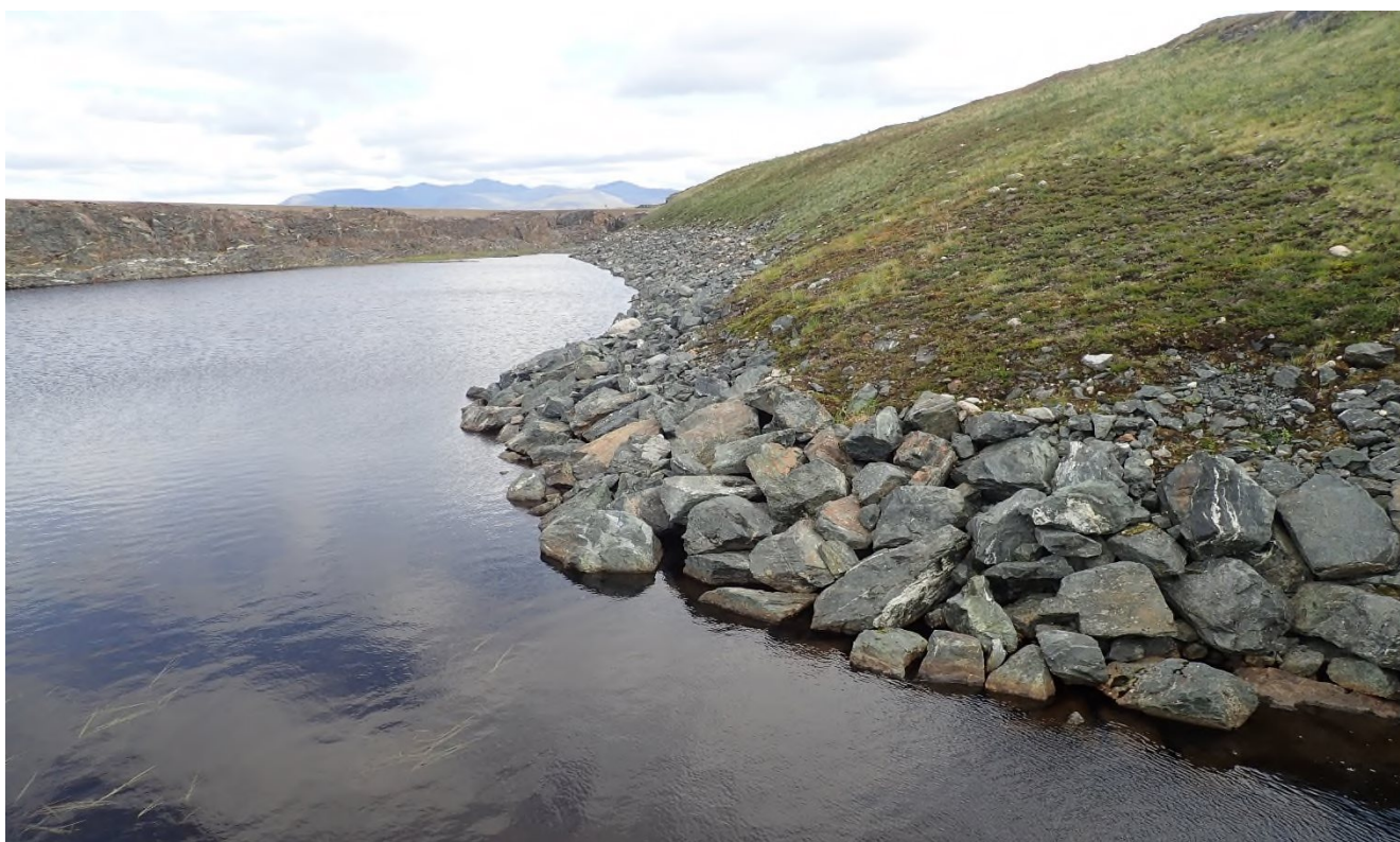
Erosjonssikring i nedre del av gjenfylling i flomkanalsteinbrudd
