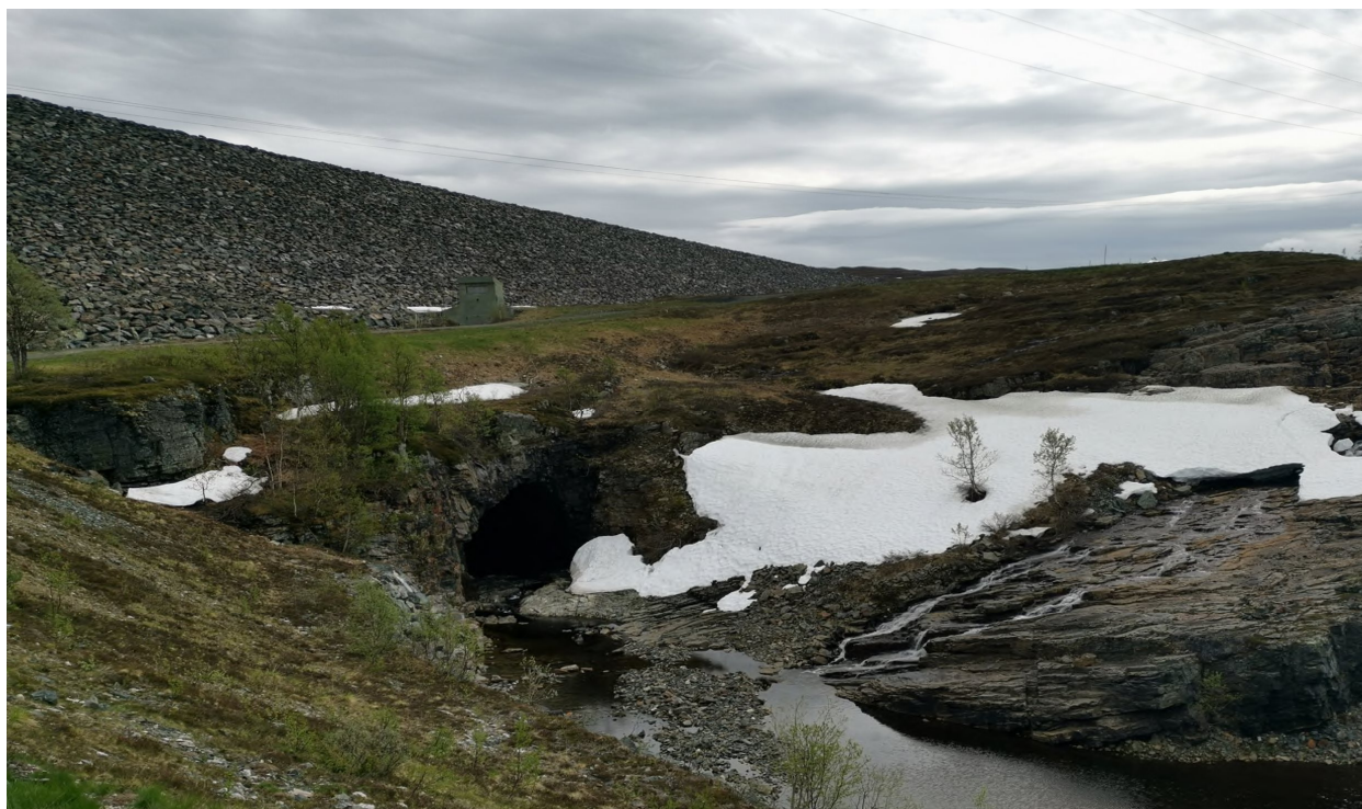
Området ved utløp omløpstunnel
