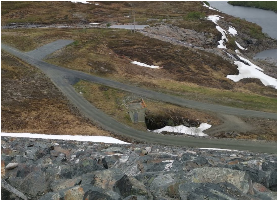
Figur 2-15: Portalbygg og forskjæring for adkomst eksisterende lukekammer sett fra damkrone
