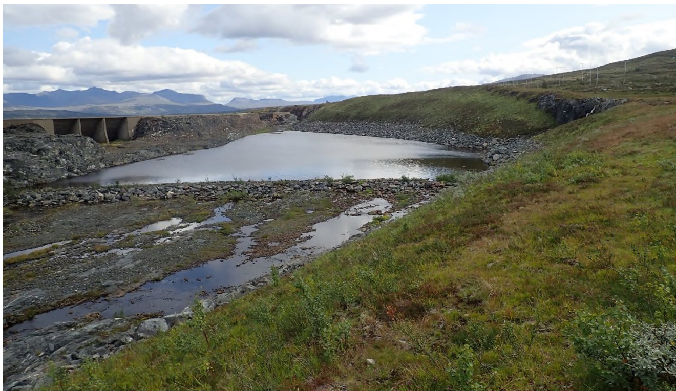
Gjenfylte og revegeterte skråninger i bruddet fra 1996-1997 til høyre i bildet
