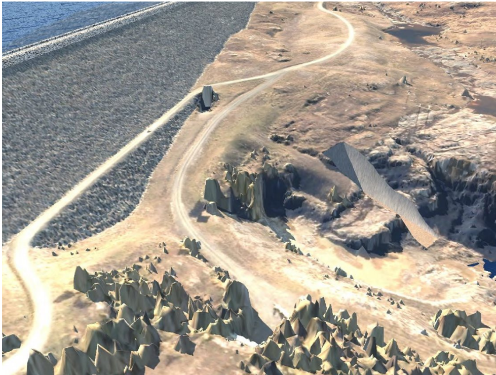
Figur 2-17: Visualisering av området nedstrøms dammen med mulig utforming av utløpskanal til ny tappetunnel.
