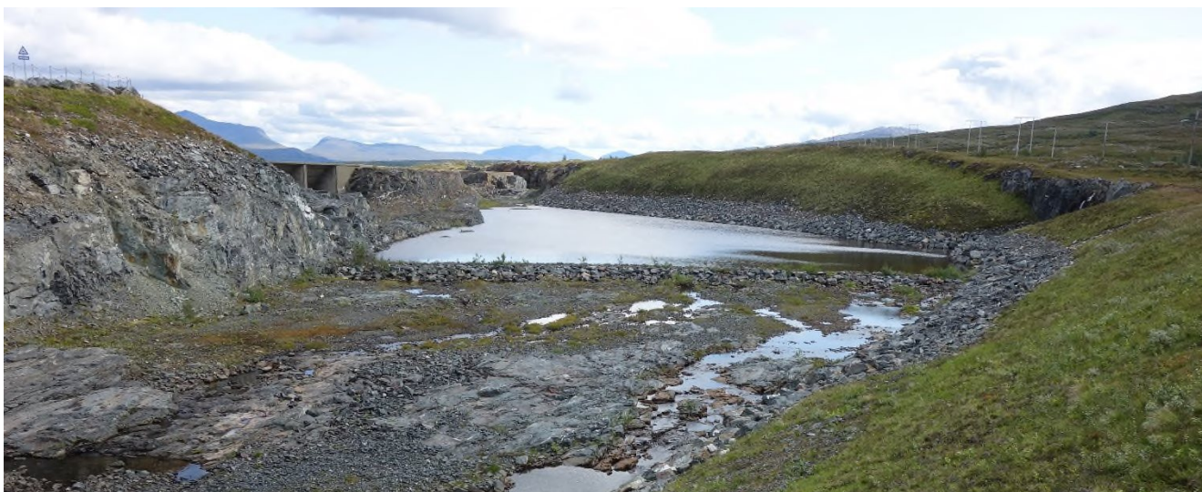
Flomkanalen sett motstrøms
