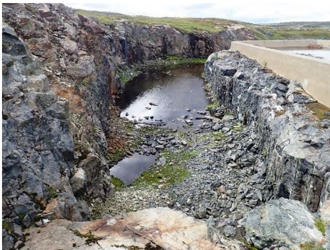
Detalj oppstrøms ende av flomkanal
