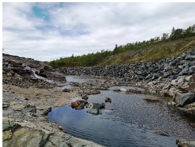
Erosjonssikring i utløp av omløpstunnel
