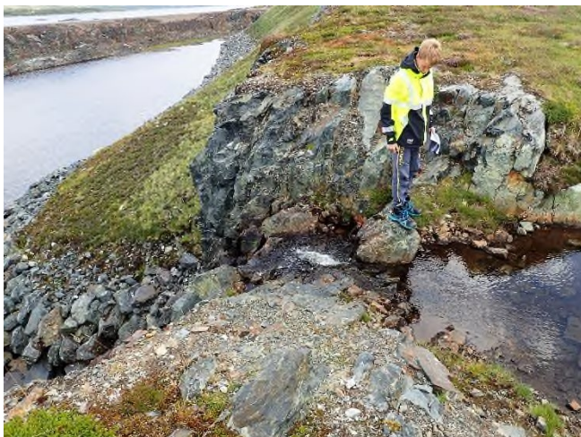
Innløp bekk i flomkanal
