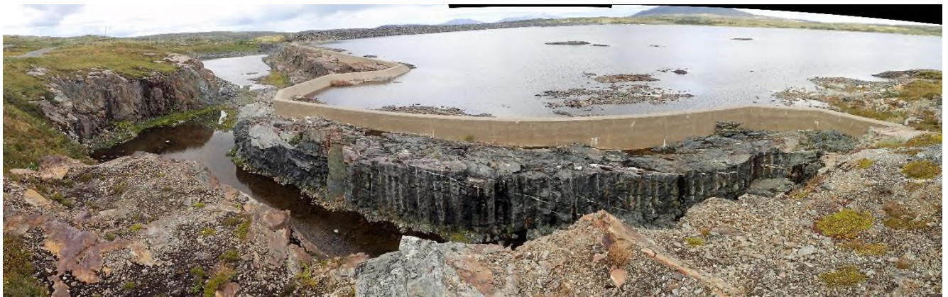
Oppstrøms ende av flomkanalen sett medstrøms
