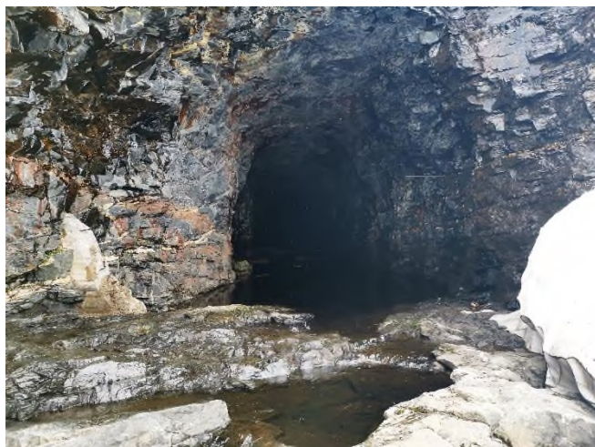
Utløp av eksisterende omløpstunnel
