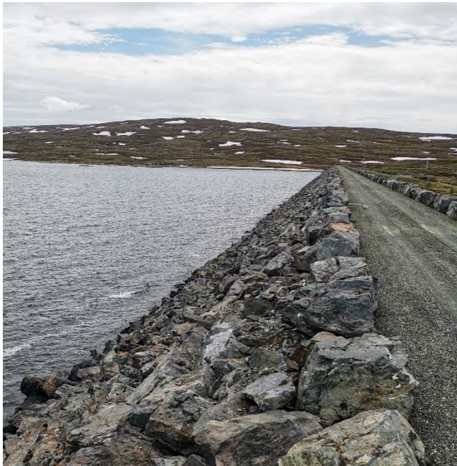
Oppstrøms damskråning sett mot sør
