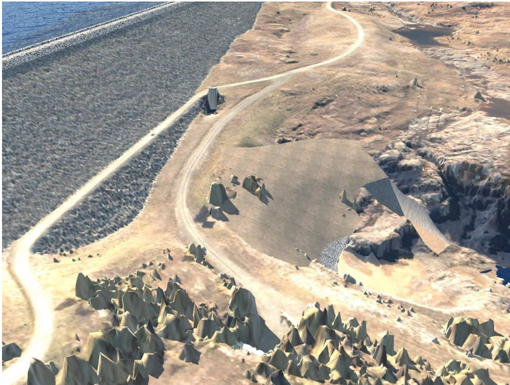
Figur 2-18: Visualisering av området nedstrøms dammen med mulig utforming av gjenfylling ved utløpet til eksisterende omløpstunnel samt gjenfylling over betongdekke for deler av utløpskanal til ny tappetunnel.
