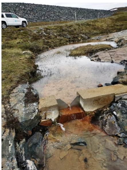
Figur 2-10: Eksisterende lekkasjemålepunkt 2 sett motstrøms
