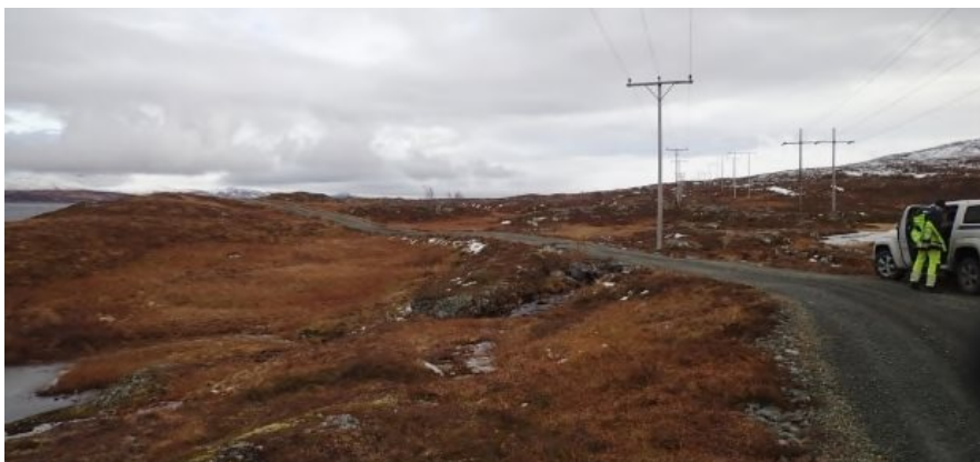
Figur 2-33: Høyspentlinjer sør for steinbrudd
