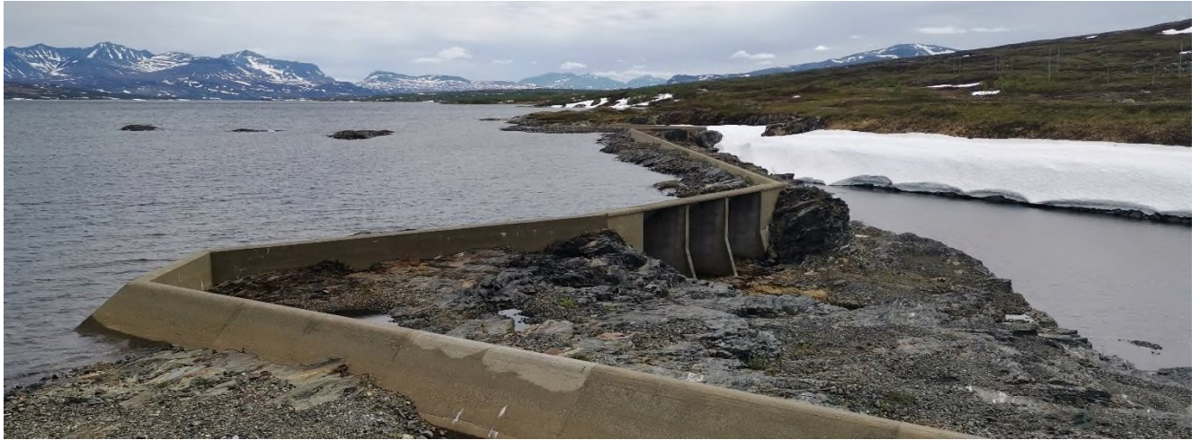
Overløpsdam sett østover fra fyllingsdammens søndre vederlag
